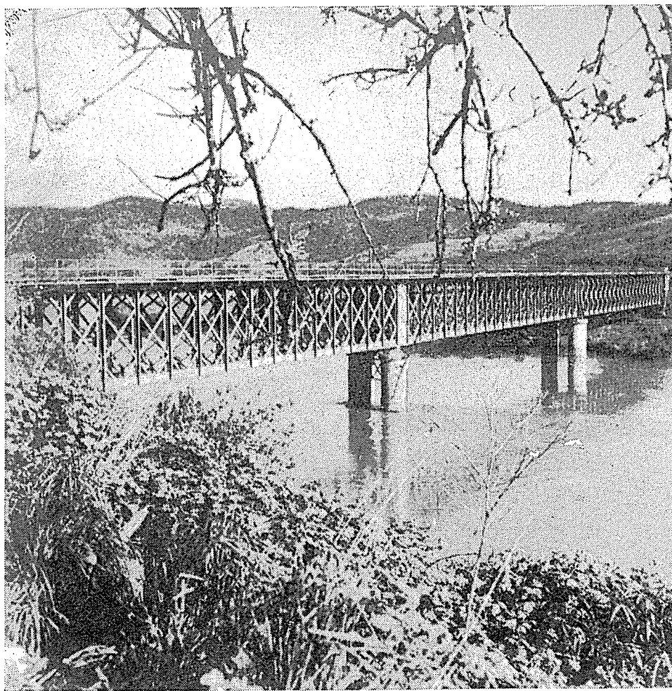
PUENTE CALLE CALLE. — KM. 833. 793. REFUERZO TIPO B.
