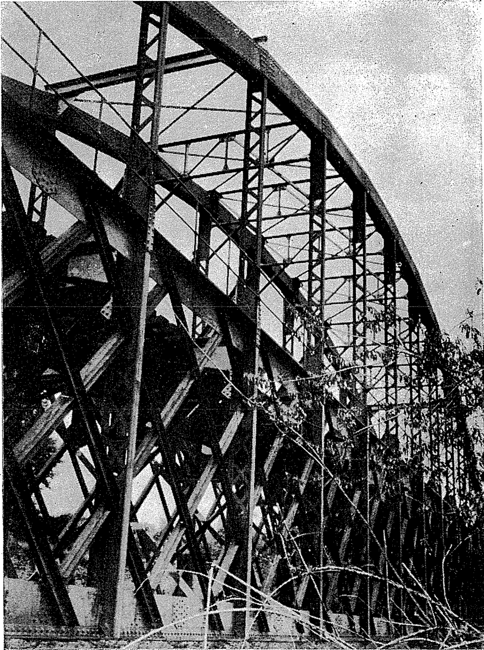
PUENTE COLLILELFU. — KM: 867.377. REFUERZO TIPO DA.
