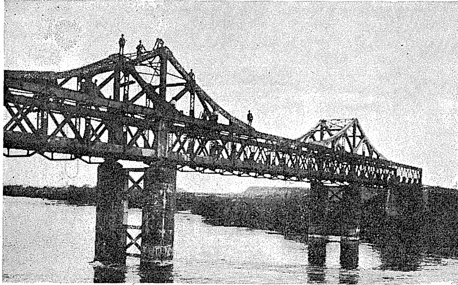
PUENTE RIO BUENO. — KM. 915.135. REFUERZO TIPO G. ARMADURA DEL REFUERZO.
