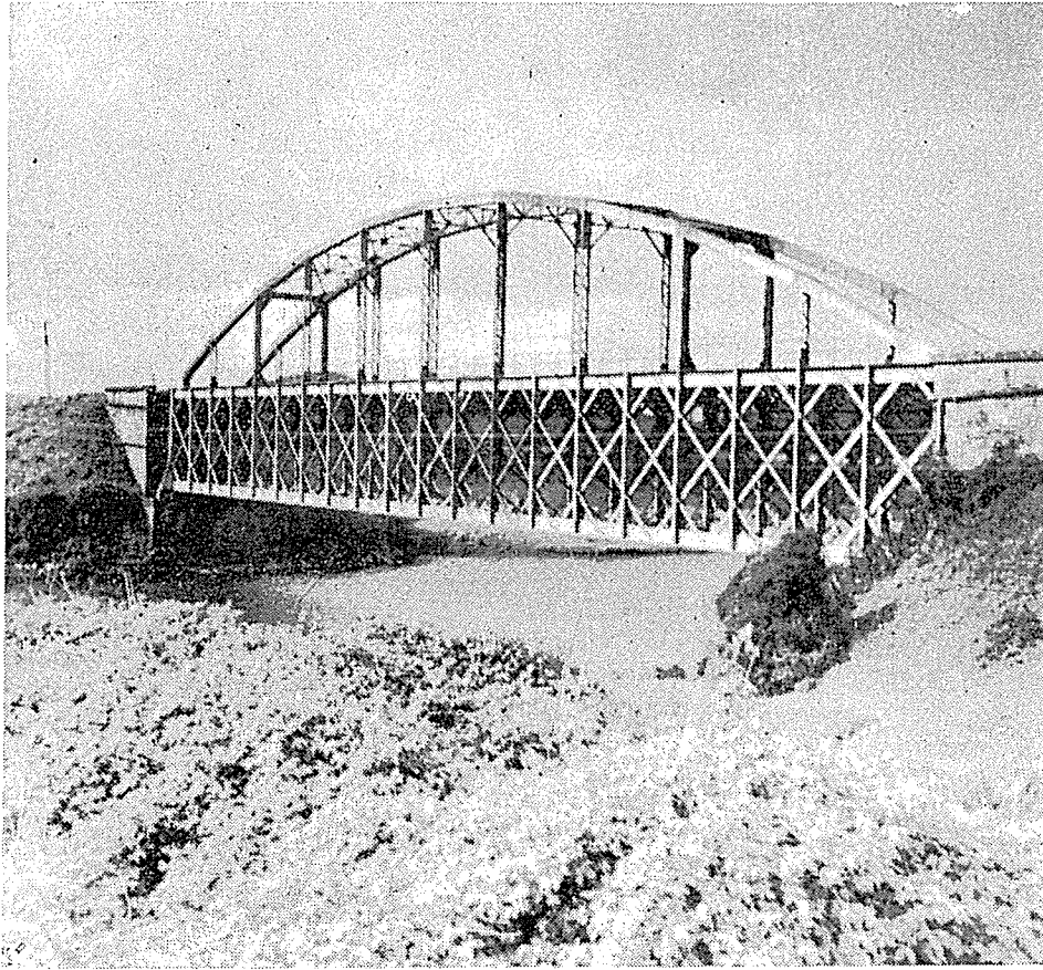
PUENTE QUEPE. — KM. 705.235. REFUERZO TIPO DA.
