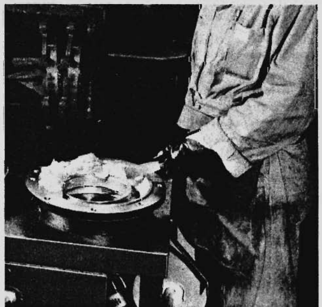
Fig. - 4 Aplicación burda de la grasa a una tapa de extremo de piñón
